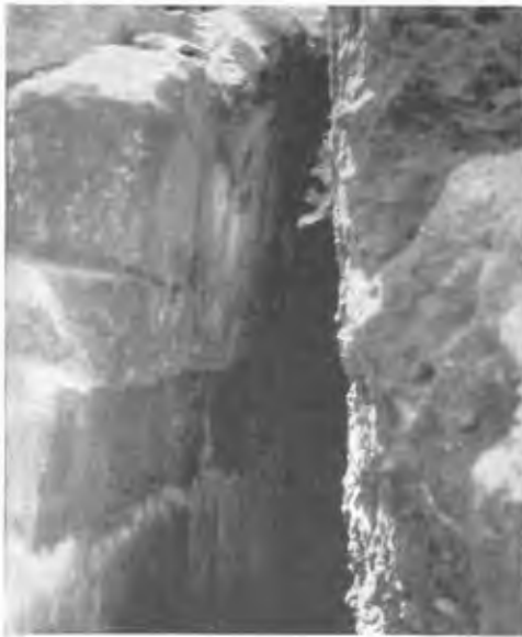
12. MIDDLE PIER: WEST SIDE.
